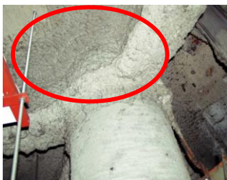
石綿含有吹付け材(レベル1)
