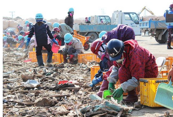
仮置場での手選別作業の様子
